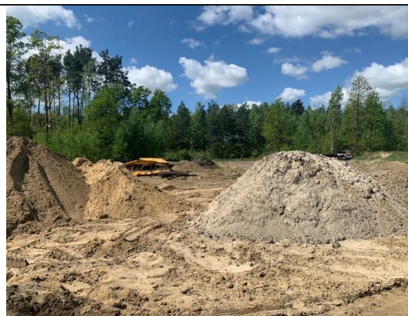
Zdj. 4 – Wyrównywanie obniżeń terenowych
