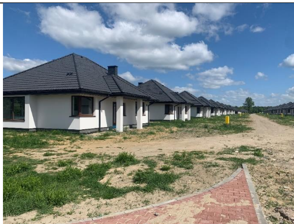
Zdj. 5 – Zabudowa mieszkaniowa realizowana z pominięciem parametrów planu miejscowego
